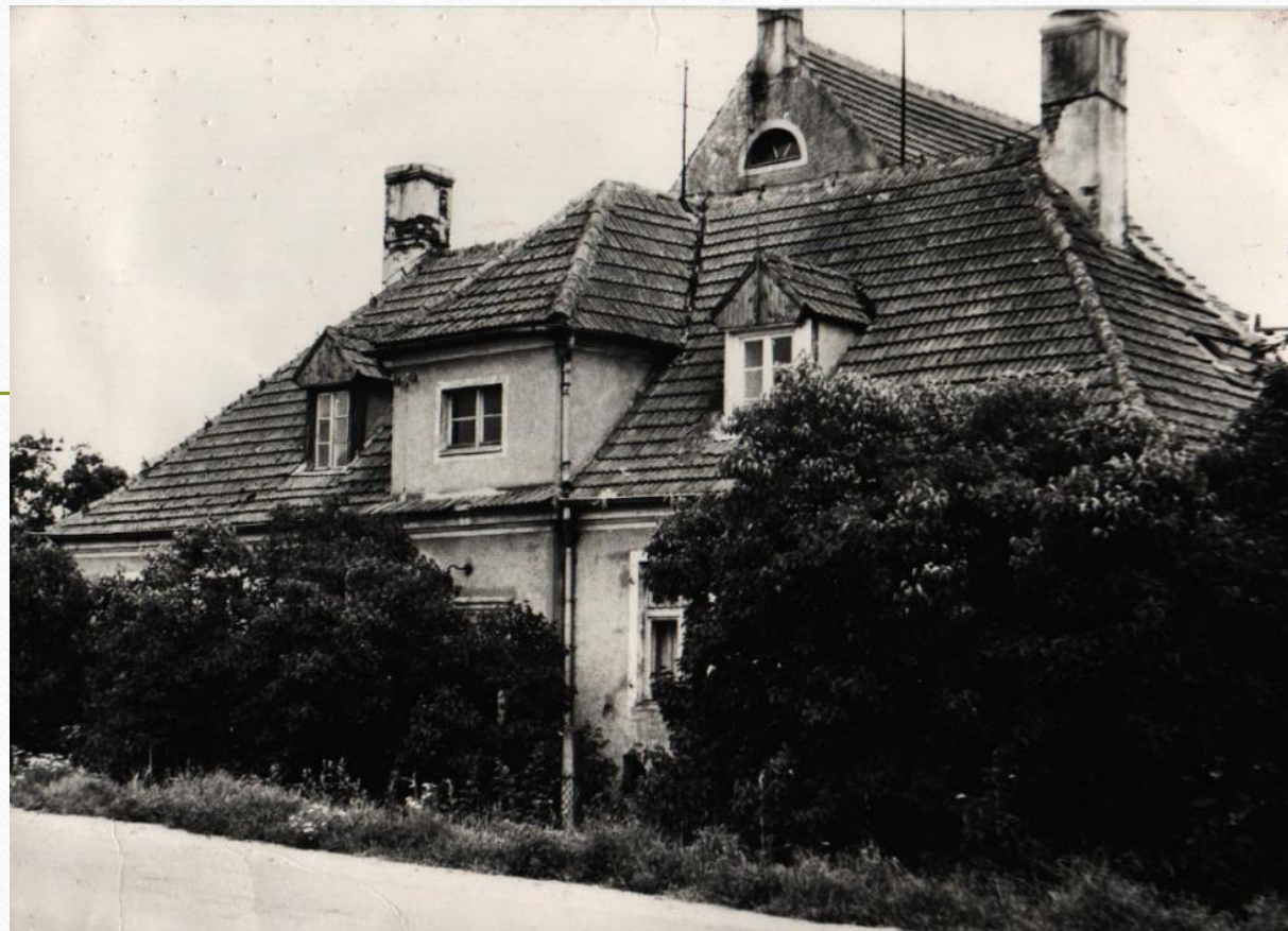
Poniemiecka rozdzielnia prądu w Łobzie, stan z lat 60 – tych
