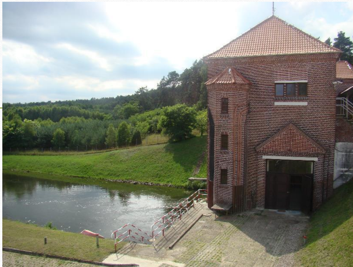
Elektrownia wodna Borowo – widok obecny
